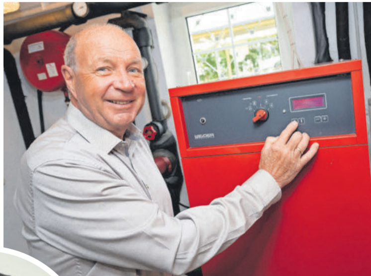
In Wolfgang Ochsenreiters Keller steht eine der ältesten Wärmepumpen Vorarlbergs. VN/SERRA
