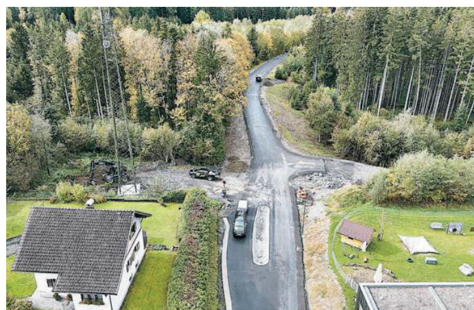
Zwei Wochen früher als geplant sind die Arbeiten fertig.
